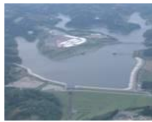
房総導水路長柄ダム
