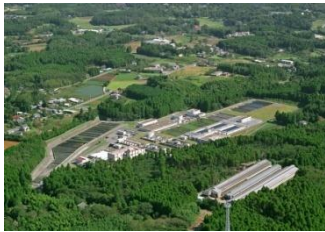
長柄浄水場 給水能力92,240m 3 /日
