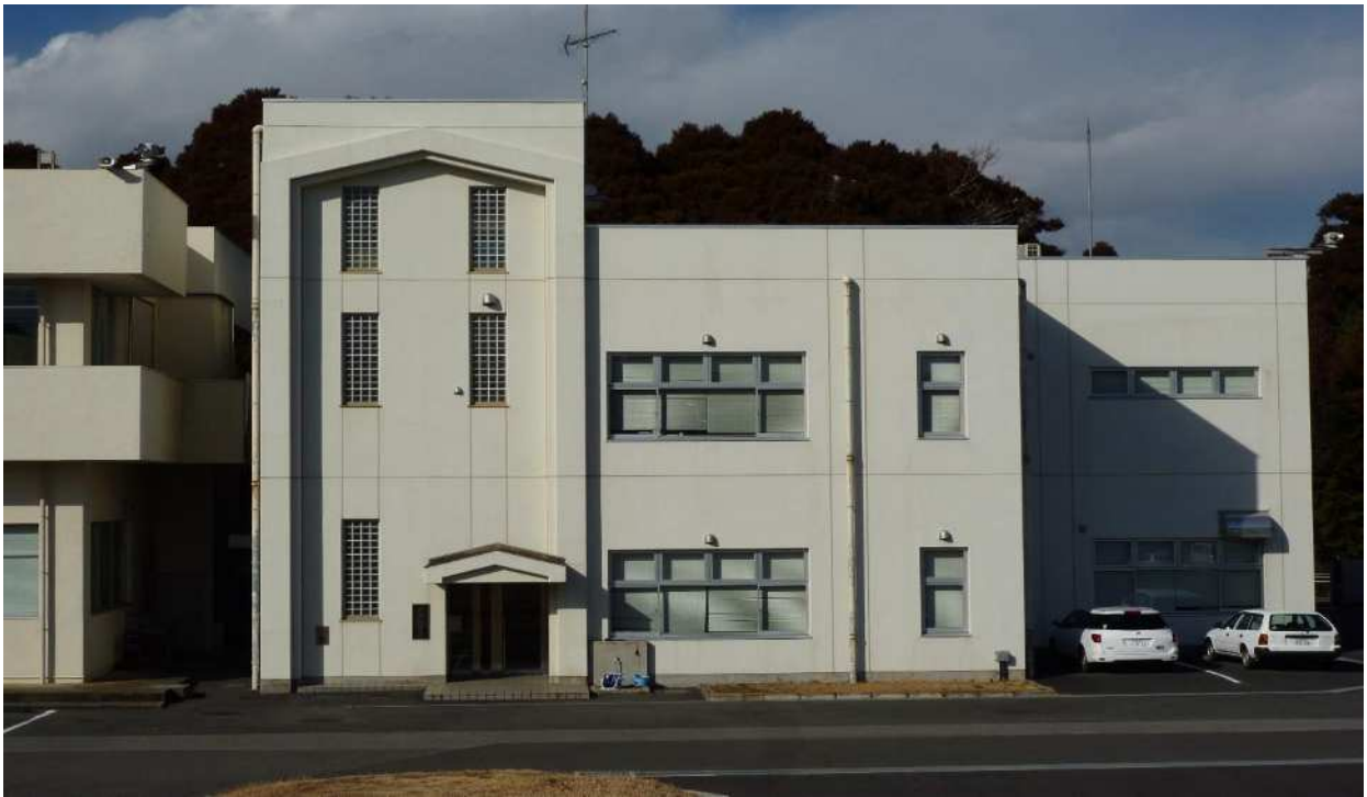
東金浄水場 水質試験棟
